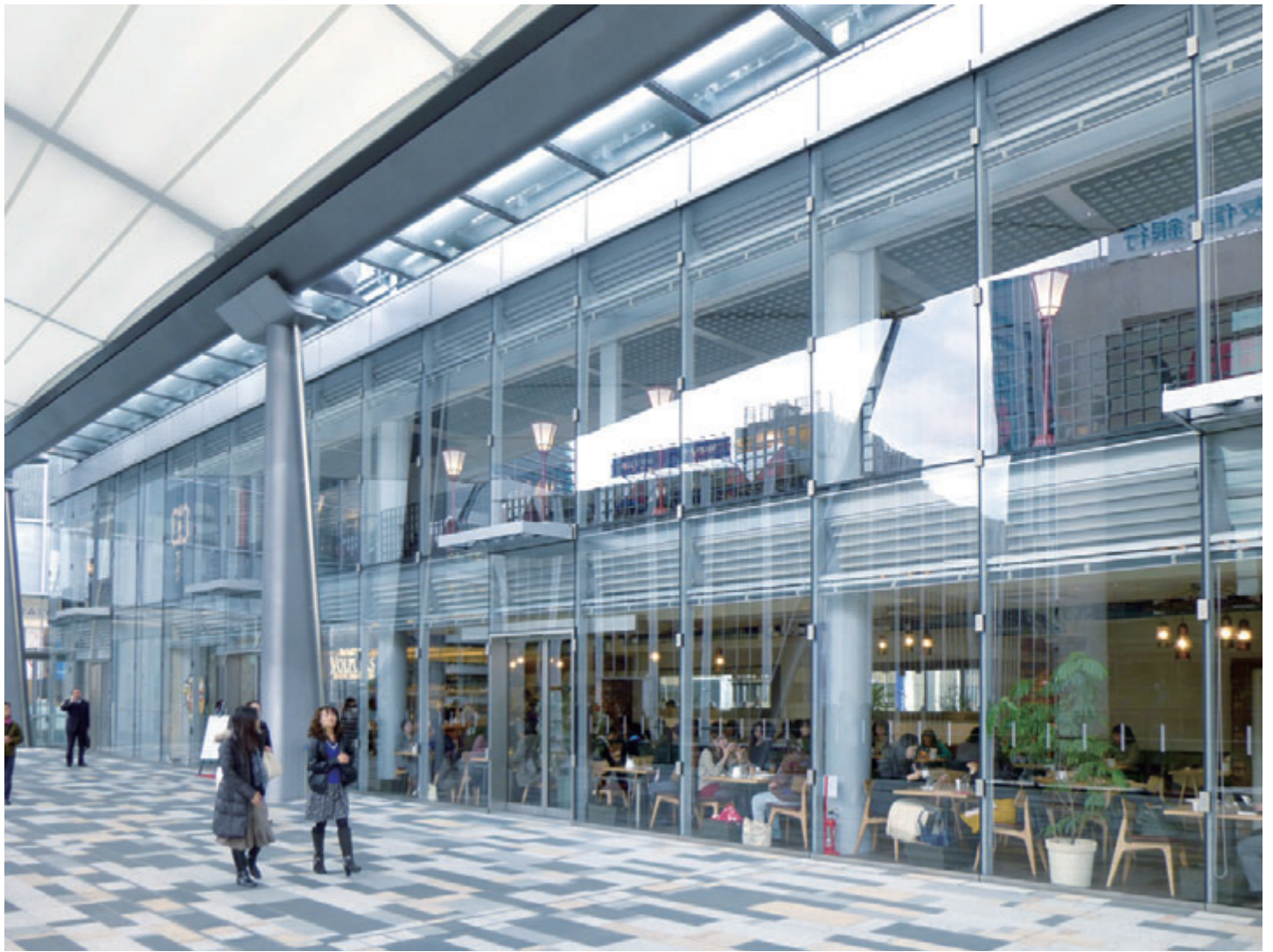
●東京駅八重洲口 グランルーフ(東京) 設計:日建設計・ジェイアール東日本建築設計事務所JV 施工:鹿島建設・鉄建建設JV 強化合わせガラス
